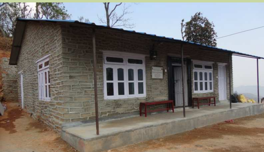
Neue Gesundheitsstation zerstört
